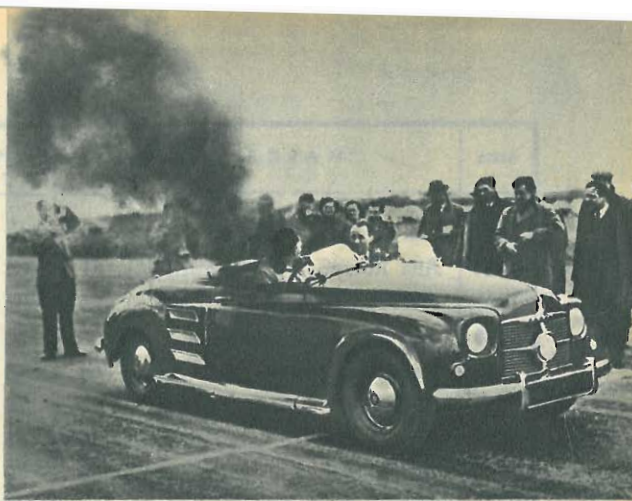
Sopra: La nuova macchina a turbina costruita dalla «Rover». Quando si mette in moto sprigiona fiamme e fumo. I tecnici della Casa assicurano che l'inconveniente sarà eliminato. Sotto a sinistra: i molti strumenti di controllo della macchina sperimentale rivelano tutte le pressioni e temperature.
