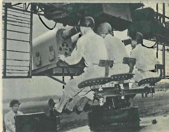
Sopra: Radar americano SCR 268. Ha tre oscillografi; è un tipo superato. Sotto: per il funzionamento occorre 4 operatori.
