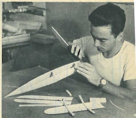
I fianchi della fusoliera sono pronti.
